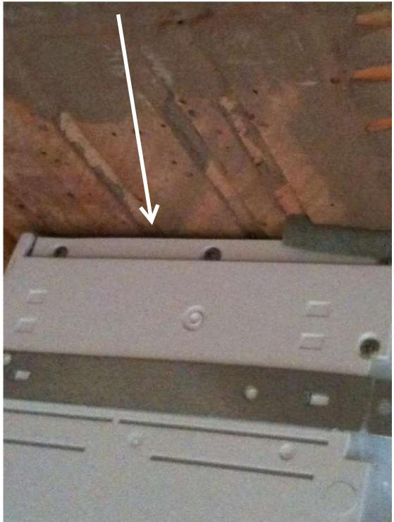
Mauvaise mise en oeuvre du compriband
