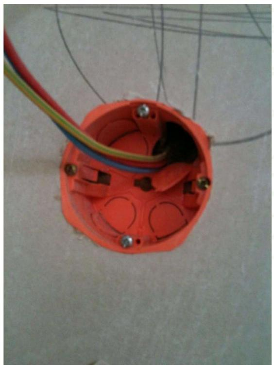
Infiltration possible au niveau des prises et interrupteurs.
